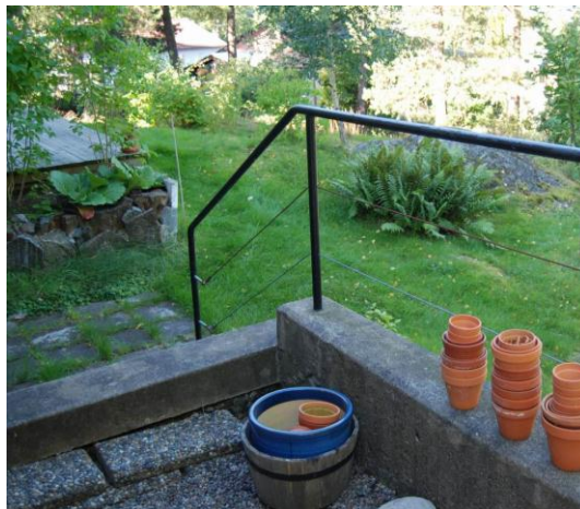
Exempel på gjuten mur, trappa och handledare. 20120906sb-019
