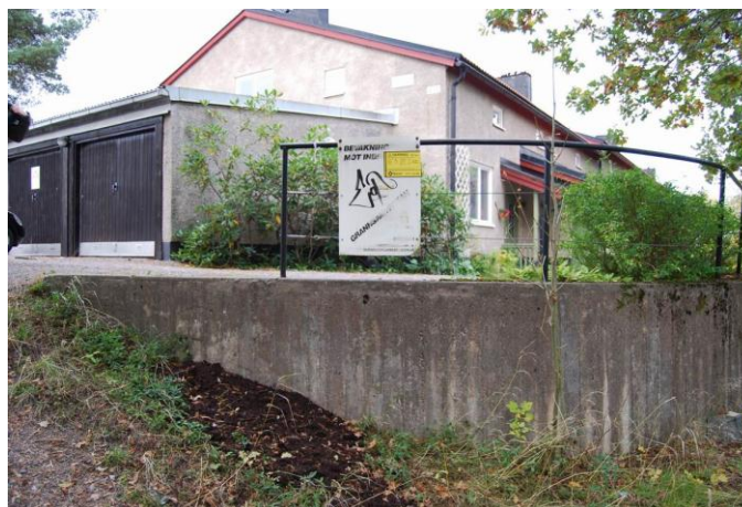
Gjutna stödmurar är typiskt för området. 20121008sb-001
