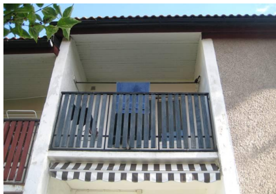
Balkongräckets utformning med smidesstomme och platta ribbor av trä. 20120921ele-032
