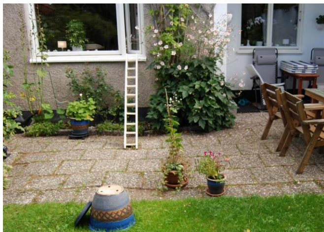
Betongplattor med sjöstensyta. 20120906sb-163
