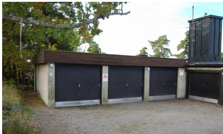
Tillbyggnaden från 1970. 20121008sb-043
