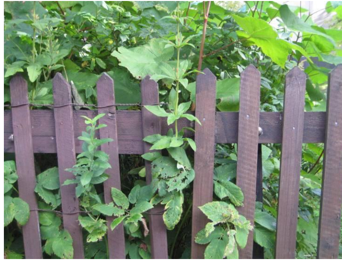
Till vänster staket av ursprunglig typ, till höger kopia utan ståltråd. 20120921ele-43 Detalj. 20120921ele-44
