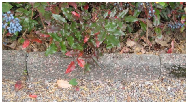
Exempel på kantstenar 20120921ele-078
