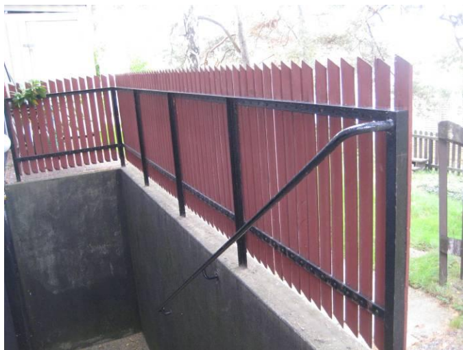
Källarnedgången till vävstugan. 20120921ele-088
