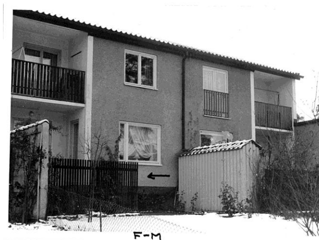
1964 (Brf arkiv, pilarna kommer från en skadebesiktning)
