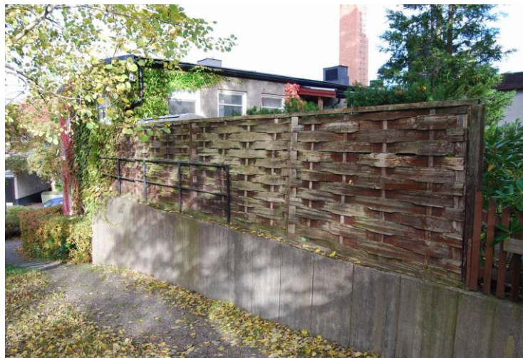
Skärm och gjuten mur. 20121008sb-046
