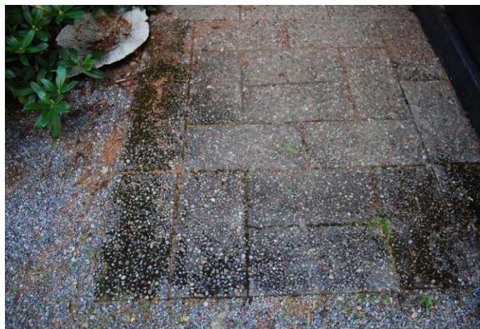
Rektangulära plattor med frilagd sjösten är mycket vanligt vid entréerna i området. 20120906sb-224
